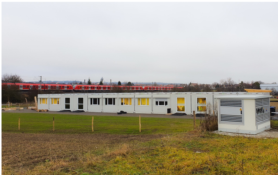
Modulare Bauweise Kinderhaus im Schelmenwiesen | Foto: Gemeinde Gärtringen
